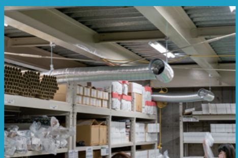
▲広い倉庫全体に空調を行き渡らせるのは至難の業！ターミナルセンターでは社員がダクトを設置し、人の集まる作業場に冷気/暖気が届くように環境改善しました。
