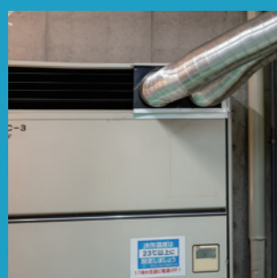
▲広い倉庫全体に空調を行き渡らせるのは至難の業！ターミナルセンターでは社員がダクトを設置し、人の集まる作業場に冷気/暖気が届くように環境改善しました。
